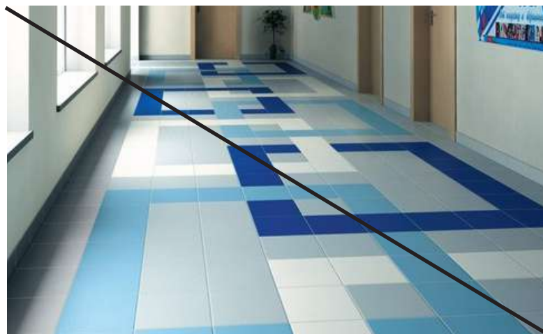
Плохо Цветные вставки из плитки
